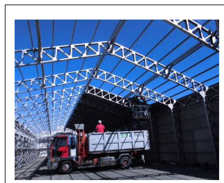
スレートの手ばらし解体
