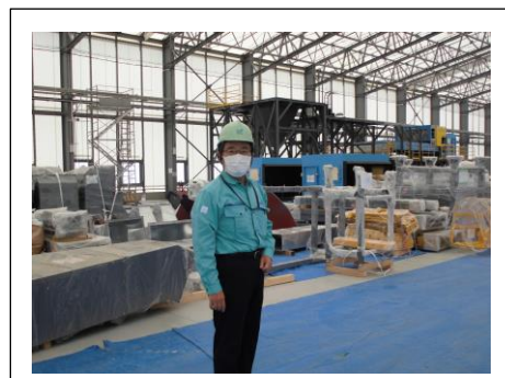
プラスチックリサイクル設備工事
