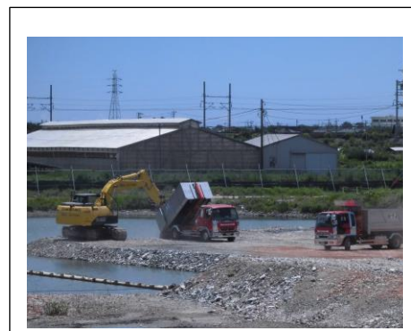
アスベスト含有スレート処分場
