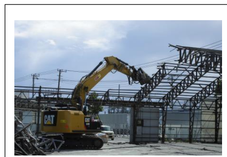
鉄骨切断・解体
